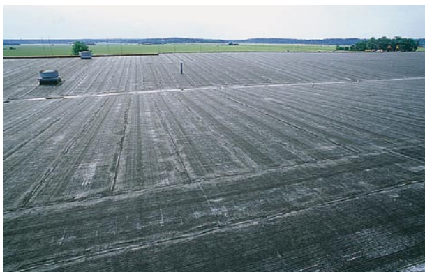
Låglutande tak täckt med Derbigum SP
