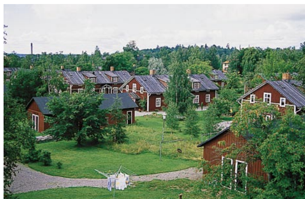
Tätskikt av Derbigum SP ovanpå befintlig plåt, kulturhus i Karlskoga
