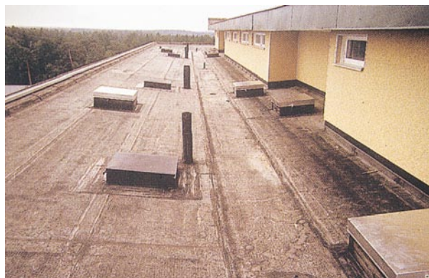
Täckning med Derbigum med anpassning till takbrunnar och rännalar
