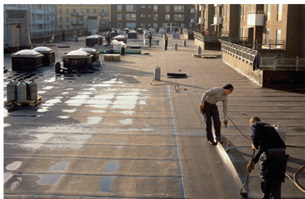
Vattenisolering med Derbigum GC på innergård
