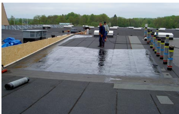
Kallklistring med Spraygun-tekniken för effektiv läggning med dubbel säkerhet
