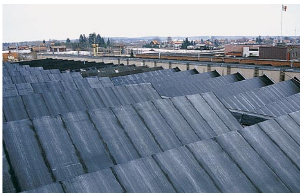
Sågtandat tak renoverat med Derbigum SP
